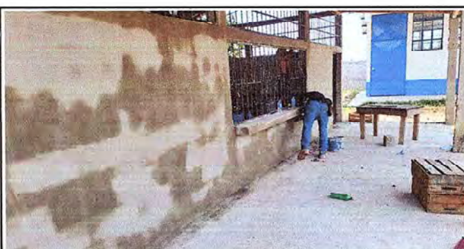
Foto 5: Culminación y repello de la cocina
