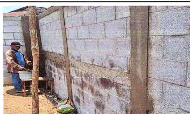
Foto 4: Seguimiento del muro perimetral
